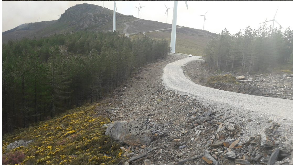
Fotos 6 e 7—Acesso com talude, vista do AG
