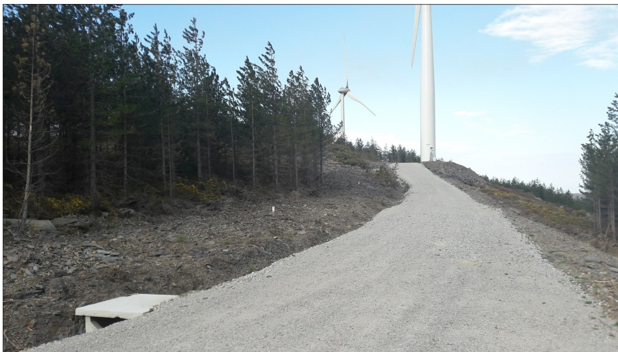
Foto 2—Acesso e vala de cabos
