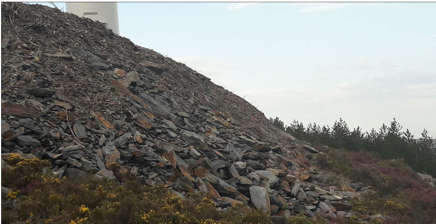
Fotos 11, 12 , 13 —Talude da plataforma com presença de herbáceas e sem sinais de erosão
