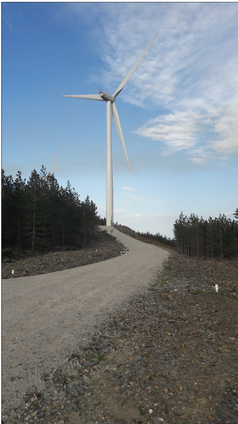
Foto 1—Acesso e vala de cabos
